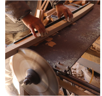
材料小割り 線引きに沿って材料を小割りする。
