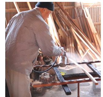
塗装 変色、汚れ防止等の為、塗装仕上げを行う。
