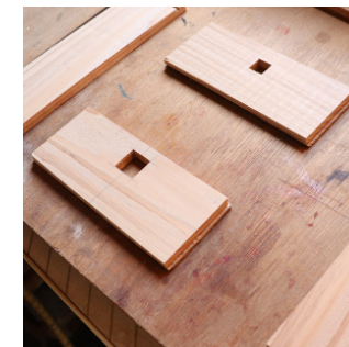
枠の組み立て 木工用ボンドをホゾ側とホゾ溝側の両方に塗ってくみ上げ装着させ、はた金を用いて締め込みを行う。
